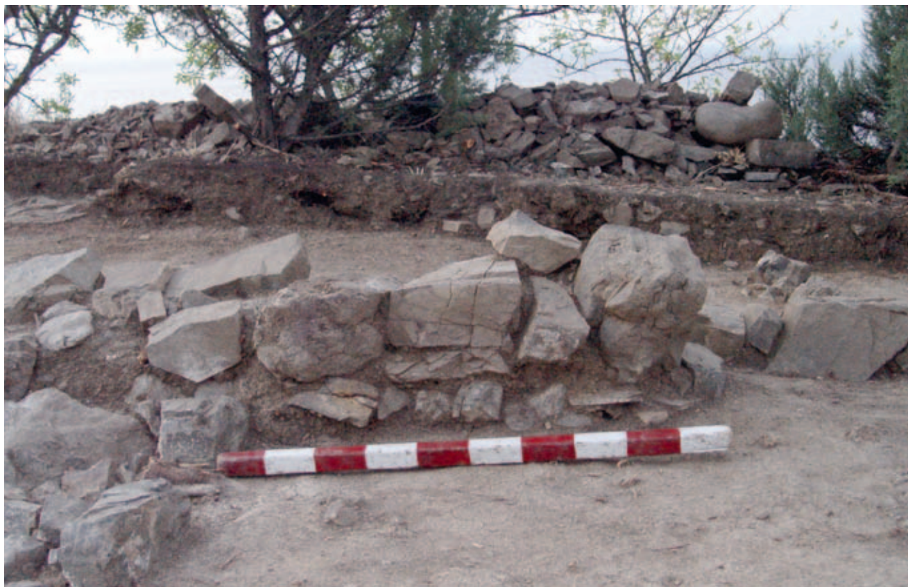
Рис. 1.48. Примыкание юго-восточной стены пристройки к первоначальному храму. Вид с северо-запада. Fig. 1.48. Joint of the southeastern wall of the northern part of the church to the church building of the first building period, view of northwest.
