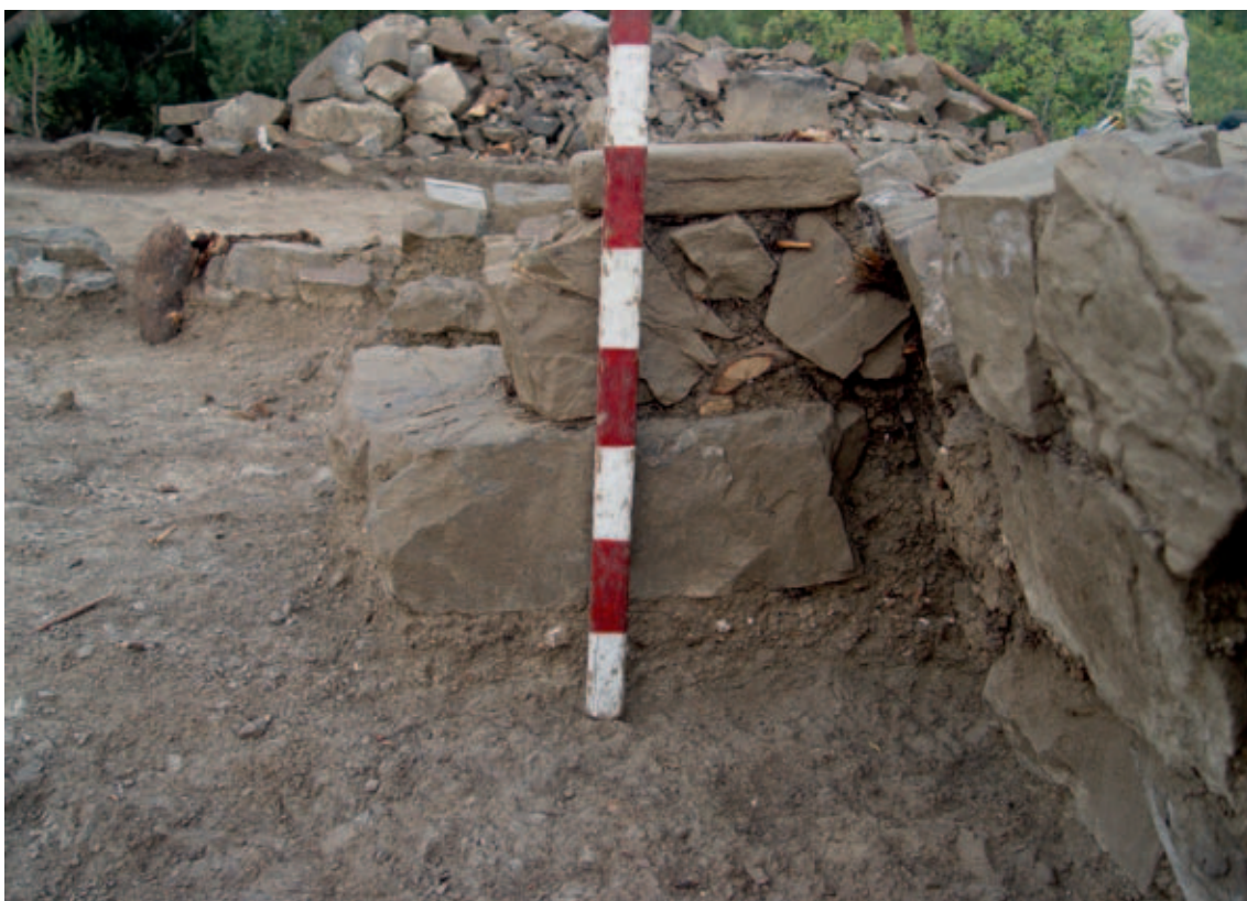
Рис. 1.51. Кладка северо-западной части перегородки южного компартамента. Вид с северо-востока. Fig. 1.51. Wall masonry of the northwestern part of the partition in the southern part of the church, view from northeast.
