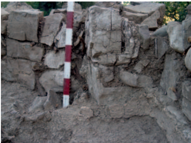
Рис. 1.12. Южная апсида. Фрагмент. Южное заплечико первого строительного периода с остатками известковой штукатурки и облицовка апсиды третьего строительного периода. Вид с юго-запада.
