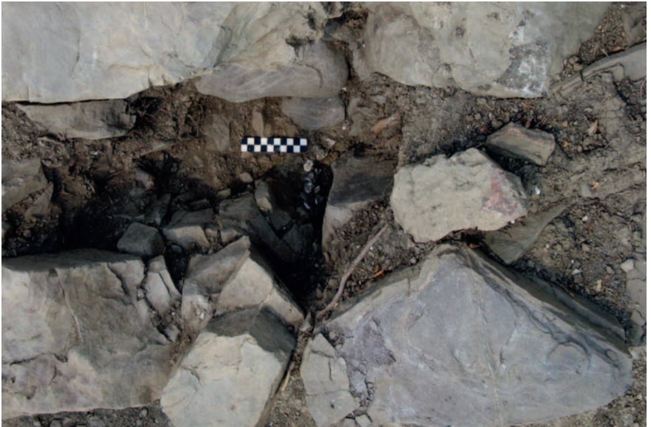
Рис. 1.23. Северный вход в храм. Фрагмент. Шов между кладками первого и третьего строительных периодов, остатки известковой штукатурки на западном откосе проёма. Вид с юго-востока, сверху.
